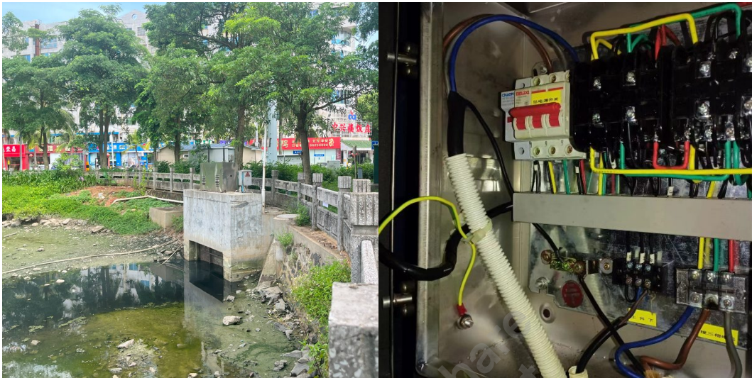
图 5-11 现状闸门及现场配套控制柜
