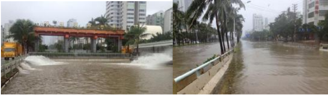
图 2.1.2-4 2014 年 9 月台风海鸥龙昆沟漫溢（防潮闸）
