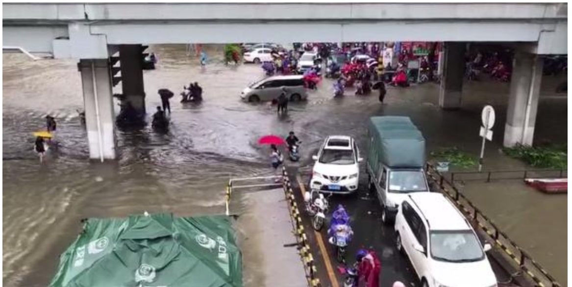
图 2.1.2-22019 年 8 月台风“韦帕”龙昆沟涝水漫溢（龙华桥）
