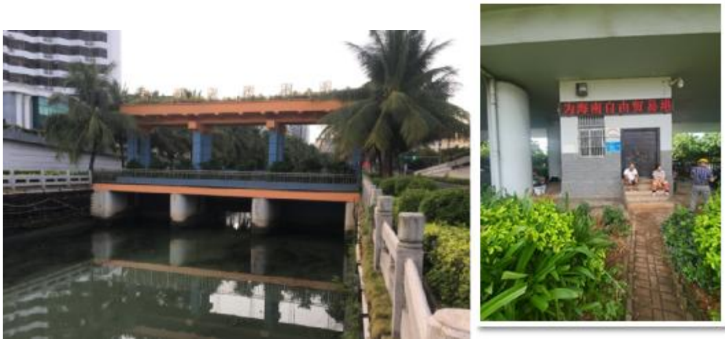
图 4.1.6-1 老防潮闸现状照片
